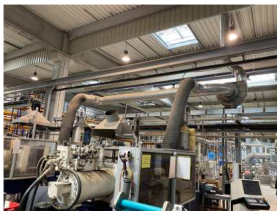
Système d'aspiration des particules presse à injecter
