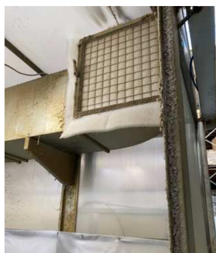
Système d'aspiration des particules cabine projection GreenAcryl
